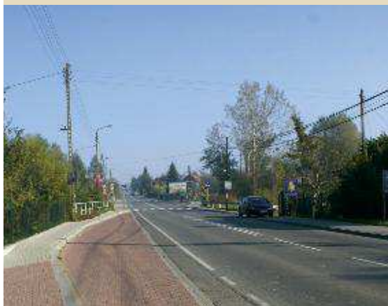
Nowy chodnik przy ul. Gdowskiej
