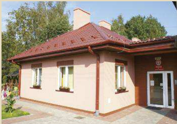
Rozbudowane przedszkole samorządowe w Śledziejowicach
